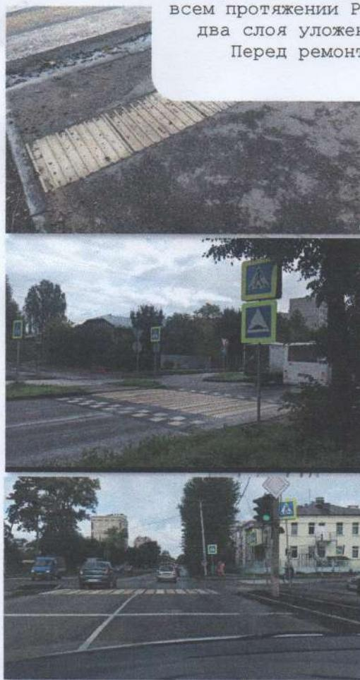
Национальный проект «БЕЗОПАСНЫЕ И КАЧЕСТВЕННЫЕ ДОРОГИ». В рамках границ **8 Городского округа** в 2021 году, проводились работы (асфальтирование) на всем протяжении Рабочего Проспекта и ул.Козуева. В ходе проведения работ в два слоя уложено асфальтобетонное покрытие, отремонтированы тротуары.
